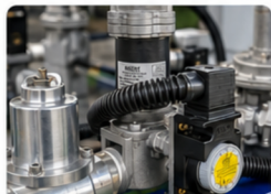
REGULADOR Y VÁLVULA SOLENOIDE
